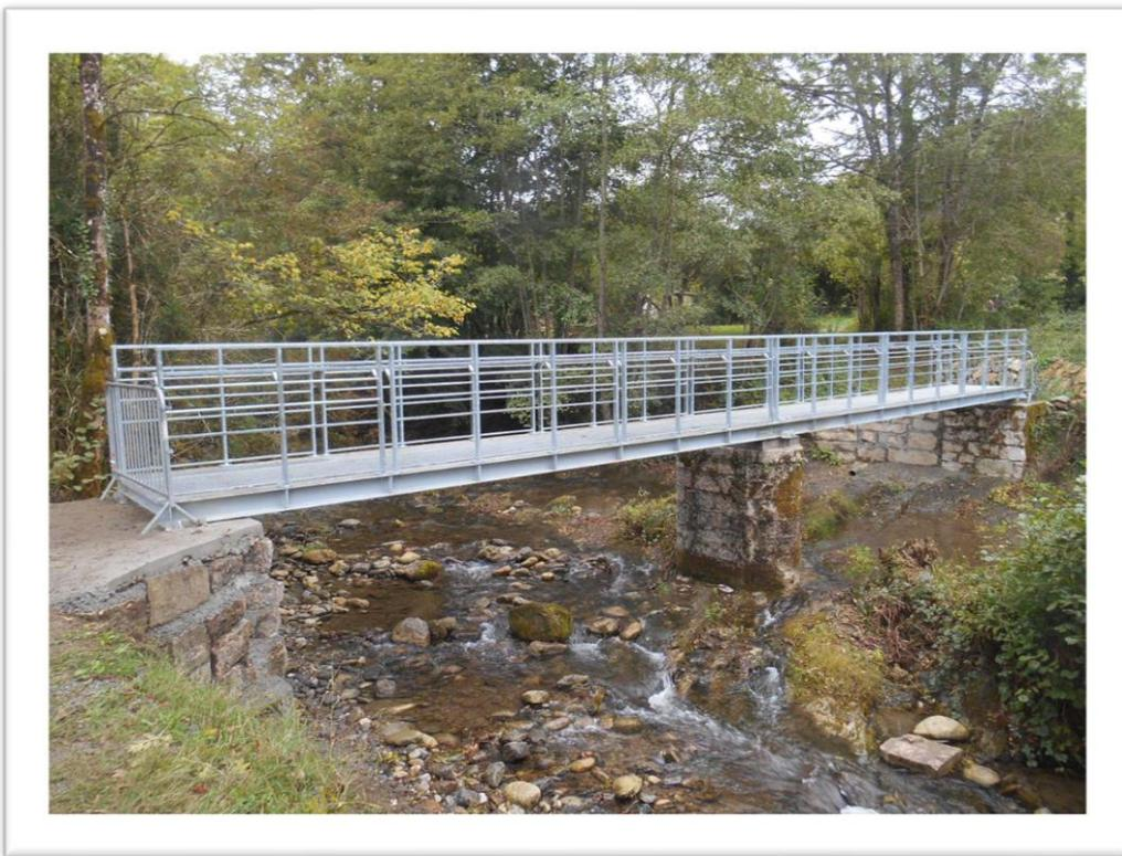
Suite aux travaux préparatoires (reprise de maçonnerie sur la pile et les culées) exécutés par nos employés communaux, l'entreprise RMAEC-SERVAT de Pamiers, titulaire du marché de travaux, a posé les 28 et 29 septembre les deux éléments de la passerelle de Camaout.
